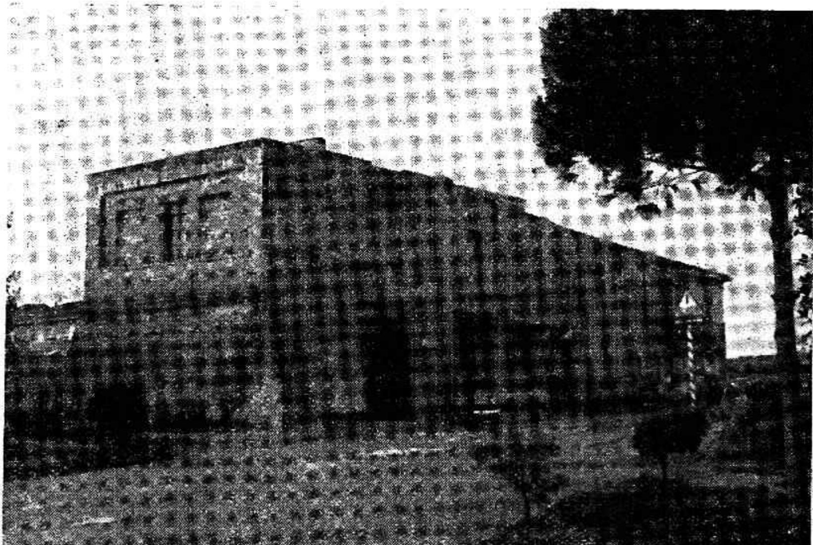
La fotografia dice lo stato attuale dei lavori. Costruiti sono il piano terreno, che è ora stato inaugurato ed è perfettamente servibile; costruito è il primo piano ma ancora non è completo dei mobili per la biblioteca ed i relativi servizi. I lavori continuano tempo e denaro permettendo.
